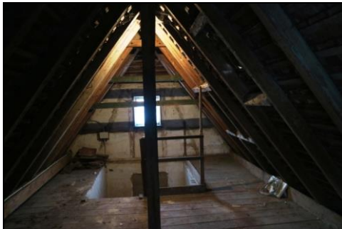
Dachstuhl des Gebäudes
