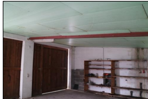
Scheune/Werkstatt mit isoliertem Dach
